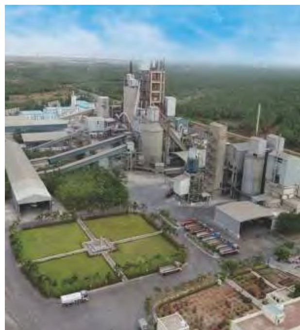
TNPL's Mini Cement Plant
