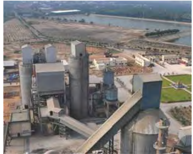
TNPL's mini Cement Plant
