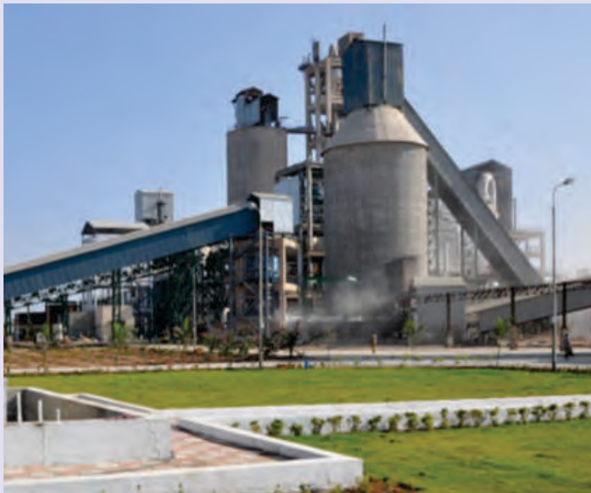
TNPL's Mini Cement Plant
